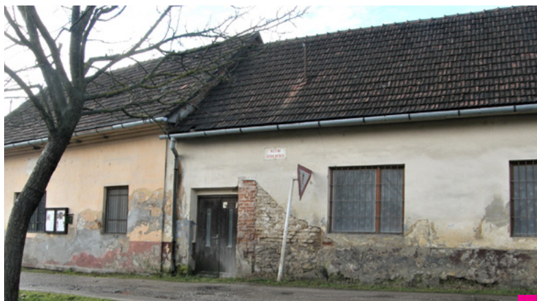
Aktuálny stav starej školy, 2021.
